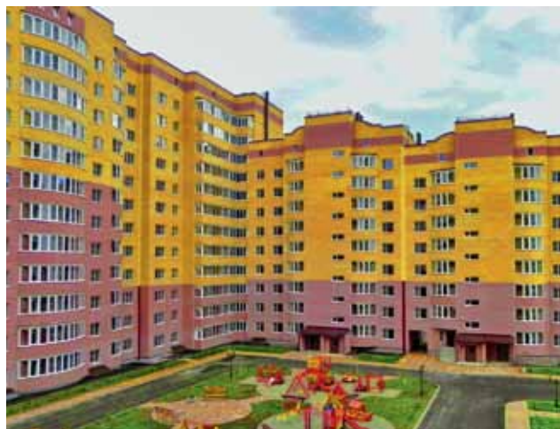
ЖИЛОЙ КОМПЛЕКС НА 378 КВАРТИР В СТАВРОПОЛЕ
