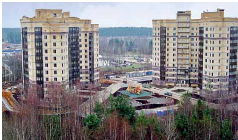
СОСНОВЫЙ БОР, ДВА ЖИЛЫХ ДОМА НА 108 И 110 КВАРТИР
