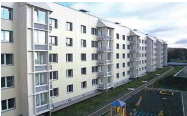
ЖИЛОЙ ДОМ, ПЕТРОПАВЛОВСК-КАМЧАТСКИЙ
