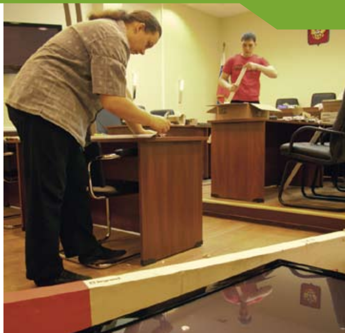
Монтаж оборудования для линии Хабаровский краевой суд — Учреждение ИЗ-27/2
