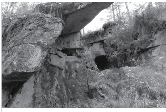
Разрушенное сооружение на р. Хара
