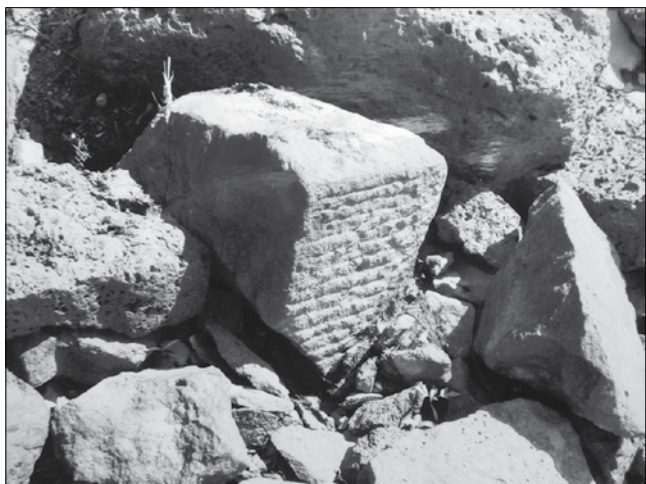
Ручная обработка стеновых камней
