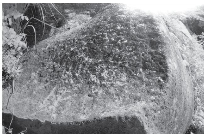
Разрушенное сооружение на р. Кия
