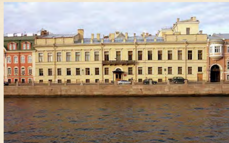
ЗДАНИЕ БЫВШЕГО ШТАБА ОКЖ, САНКТ-ПЕТЕРБУРГ, НАБЕРЕЖНАЯ ФОНТАНКИ, 16. ЗДЕСЬ ПРОЖИВАЛ И МИНИСТР ВНУТРЕННИХ ДЕЛ ПАВЕЛ ДУРНОВО
