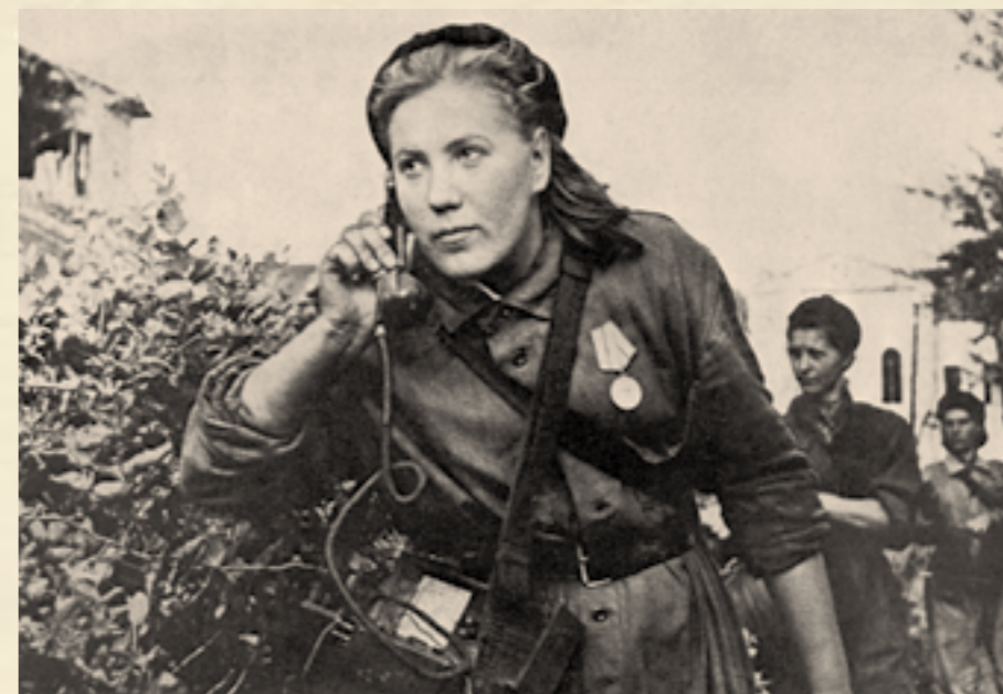
СВЯЗИСТКИ МЕСТНОЙ ПРОТИВОВОЗДУШНОЙ ОБОРОЫ ЛЕНИНГРАДА В. КЛЕПИКОВА, А. ЕГОРОВА И А. КОВАЛЕВА ВОССТАНАВЛИВАЮТ ПОВРЕЖДЕННУЮ ЛИНИЮ СВЯЗИ. АВГУСТ 1943 ГОДА
