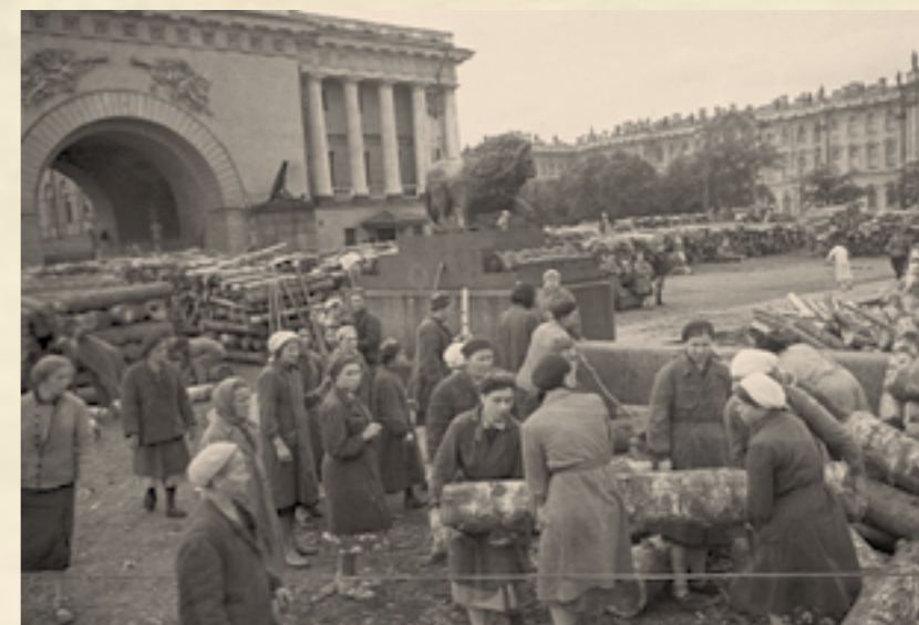
ЛЕНИНГРАДЦЫ СООРУЖАЮТ УКРЕПЛЕНИЯ НА УЛИЦАХ ГОРОДА
