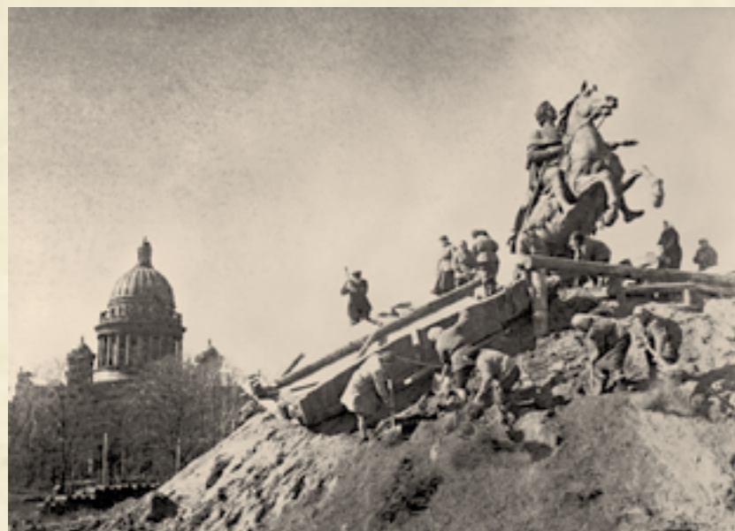
РАБОТЫ ПО СОХРАНЕНИЮ ПАМЯТНИКОВ В БЛОКАДНОМ ЛЕНИНГРАДЕ. ПАМЯТНИК ПЕТРУ I («МЕДНЫЙ ВСАДНИК») УКРЫВАЮТ МЕШКАМИ С ПЕСКОМ, ОБШИВАЮТ ДОСКАМИ. СЕНТЯБРЬ 1941 ГОДА
