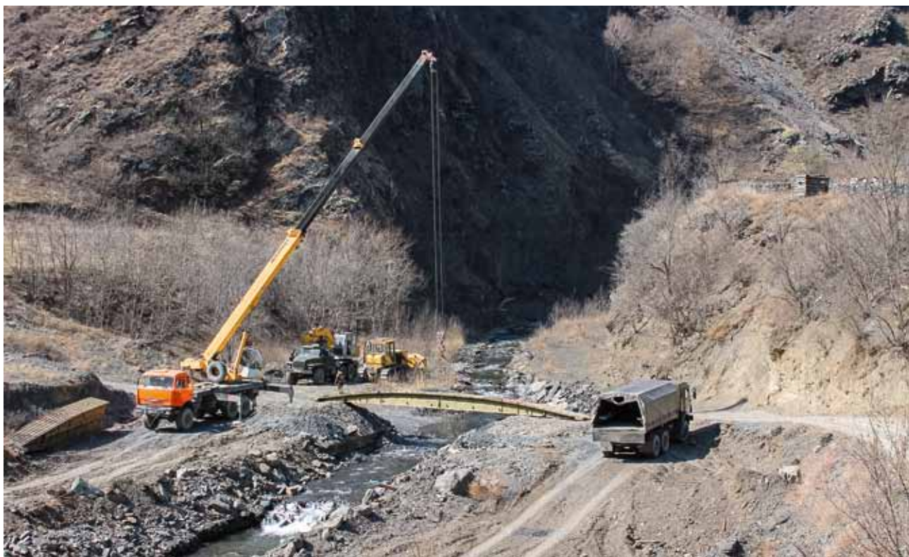
НА ОТКРЫТОМ ПРОСТРАНСТВЕ, КУДА МОЖНО БЕСПРЕПЯТСТВЕННО ПОДОГНАТЬ СТРОИТЕЛЬНУЮ ТЕХНИКУ, МОСТЫ УСТАНОВЛИВАЮТ БЫСТРО
