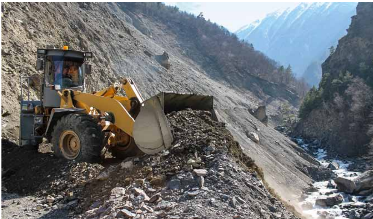
РАСЧИСТКА одного из участков ДОРОГИ
