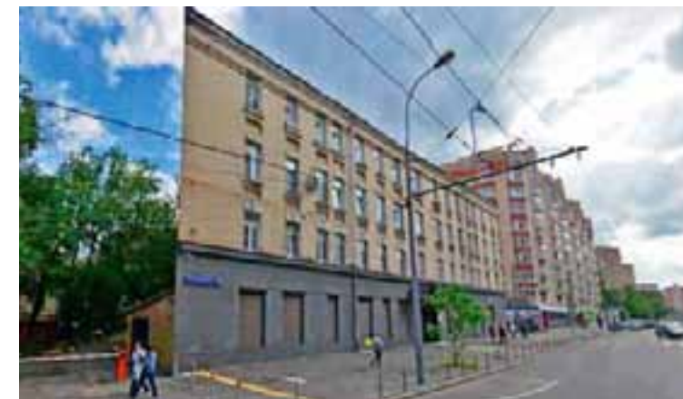
«ПЛОСКИЙ ДОМ» НА ПРЕСНЕНСКОМ ВАЛУ
