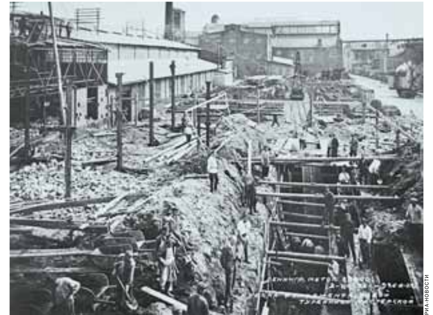
ЗАКЛАДКА ФУНДАМЕНТА НОВОЙ ТУРБИНОЙ МАСТЕРСКОЙ ЛЕНИНГРАДСКОГО МЕТАЛЛИЧЕСКОГО ЗАВОДА, 1926 ГОД
