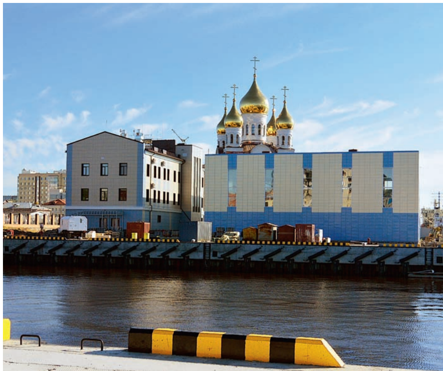
ДЛЯ ОБЕСПЕЧЕНИЯ ДЕЯТЕЛЬНОСТИ ФЕДЕРАЛЬНОЙ СЛУЖБЫ БЕЗОПАСНОСТИ РОССИЙСКОЙ ФЕДЕРАЦИИ ОСУЩЕСТВЛЯЕТСЯ ПРОЕКТИРОВАНИЕ ЗДАНИЙ САМОГО РАЗНОГО НАЗНАЧЕНИЯ
