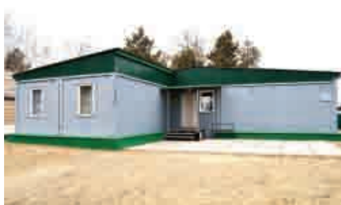
ОТДЕЛЕНИЕ МОДУЛЬНОГО ТИПА В НАСЕЛЕННОМ ПУНКТЕ КАСАТКИНО СОБИРАЛИ, КОМБИНИРУЯ БЛОКИ-МОДУЛИ В НУЖНУЮ КОНФИГУРАЦИЮ
