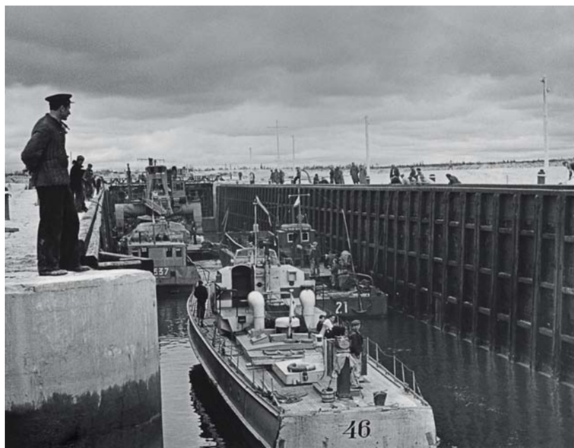
АЛЕКСАНДРУ ПОРОХОВЩИКОВУ ПРИШЛОСЬ ПРОЕКТИРОВАТЬ ГИДРОСООРУЖЕНИЯ БЕЛОМОРКАНАЛА
